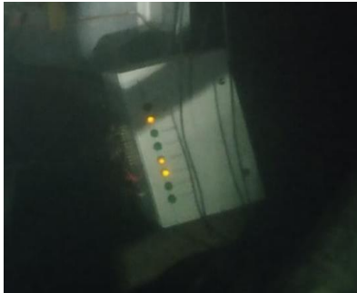
Figura 8 Instalación y Pruebas UTRB
