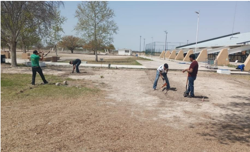
Figura 7 Cierre de las líneas excavadas
