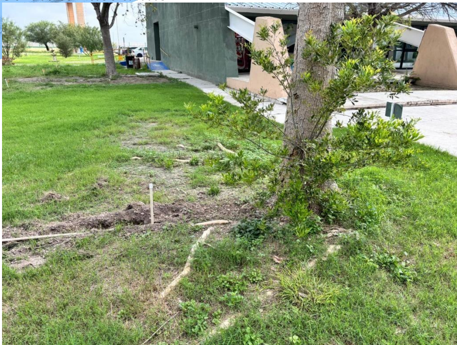
Figura 8 Cierre de las líneas excavadas
